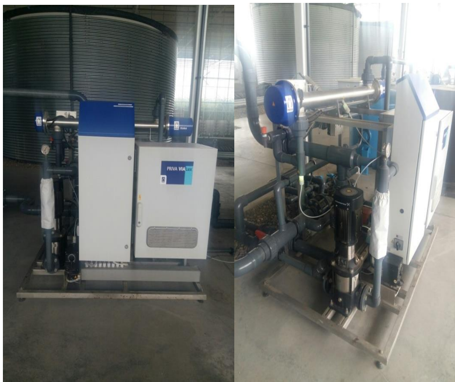
1.3 Сурет - Priva Vialux ультракүлгін сәулелер арқылы су тазартқыш қондырғысы
